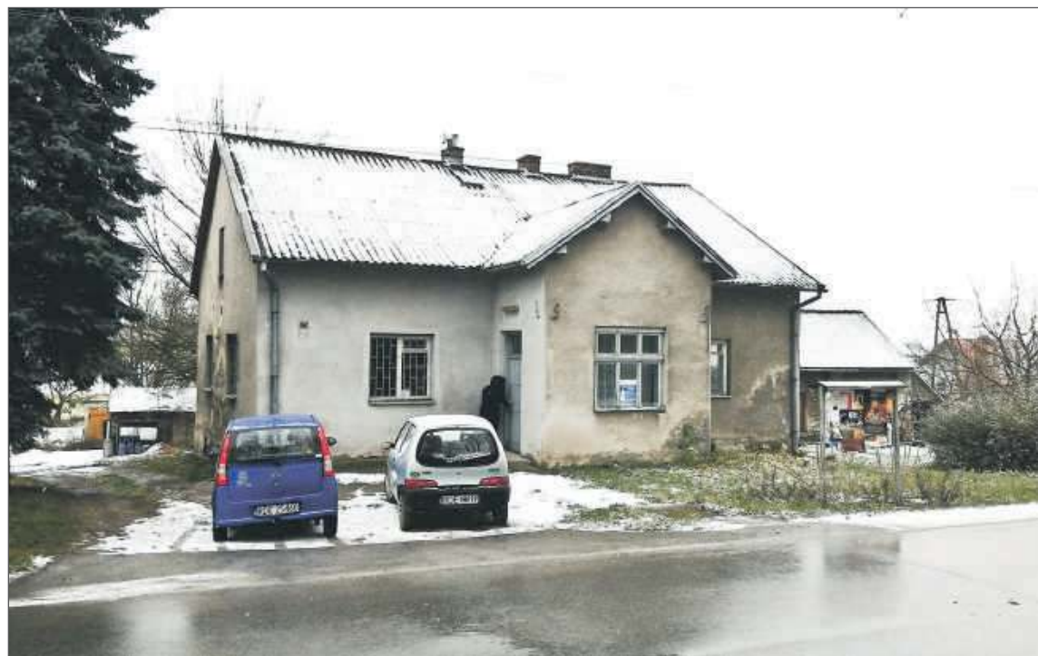
Budynek starej biblioteki z Zasowie - dach został wymieniony w ubiegłym roku.
