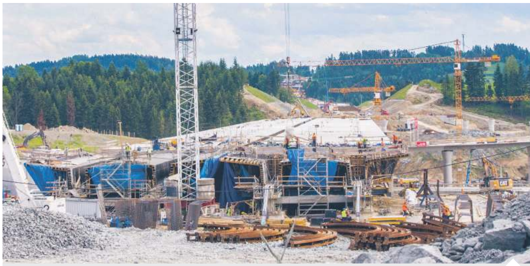
Wykonawcy autostrad nie dostaną dodatkowych pieniędzy za kontrakty | fot. Tomasz Hamrat/Gazeta Polska
