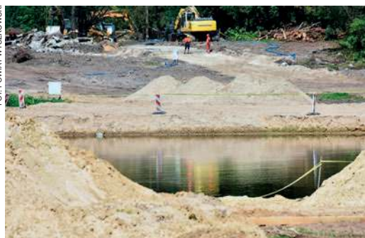
Wykonawca już przygotował grunt pod budowę mostu.
