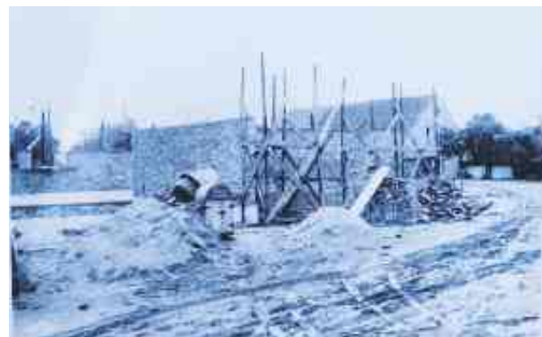
Budowa nowego pawilonu meblowego GS w Przewornie. Dziś mieści się tam sklep Lewiatan
