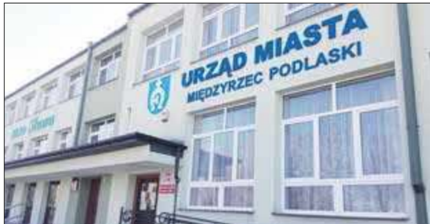
Radni zdecydowali, że opłaty targowe, stawki podatku od środków transportowych oraz stawki podatku od nieruchomości w Międzyrzeczu Podlaskim pozostaną w przyszłym roku takie same jak w roku 2020
