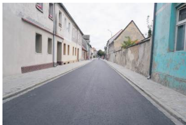
Zakończono remont ul. Strzelińskiej w Wiązowie
