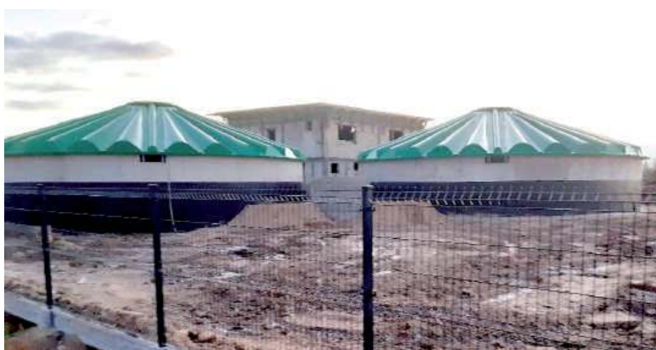
Kopuły z zielonymi dachami to są reaktory, w których odbywa się proces oczyszczania ścieków
