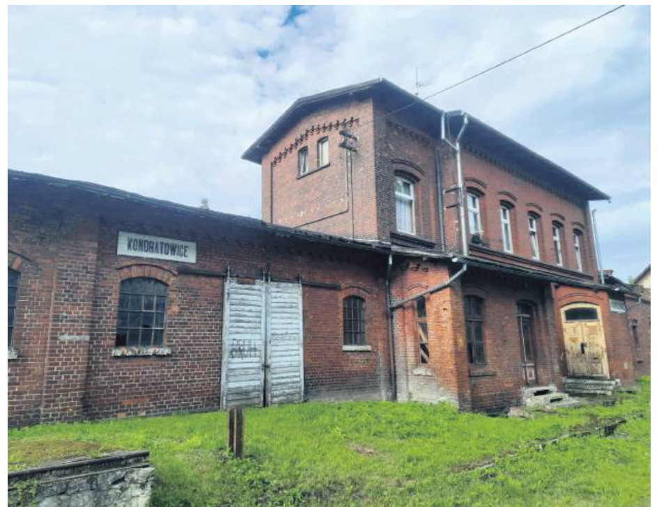
Gmina Kondratowice otrzymała 1 mln zł na remont budynku po byłym dworcu PKP w Kondratowicach. Fot. UG Kondratowice
