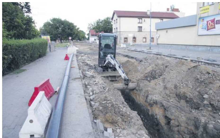
Prace rozpoczęły się z początkiem lipca, a mają być zakończone w ciągu 4 miesięcy. Foto: UMIG Strzelin
