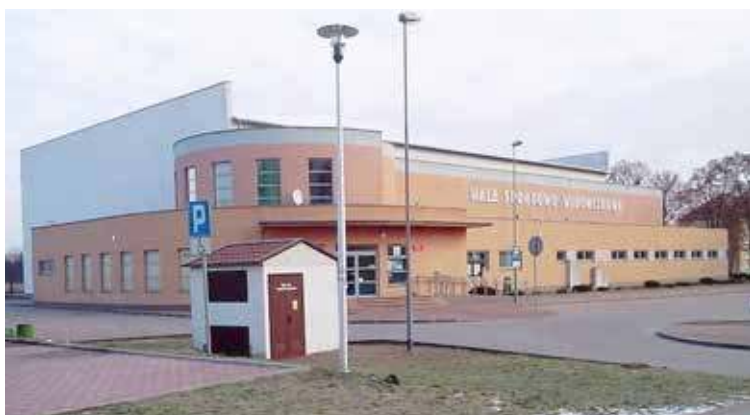
Hala sportowo-widowiskowa w Łobzie
