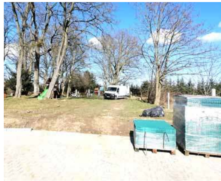
Wykonawca rozpoczął prace nad miniparkiem
