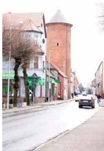
Wymienionych zostanie m.in. 885 przestarzałych opraw świetlnych (fot. Gm. Maszewo)
