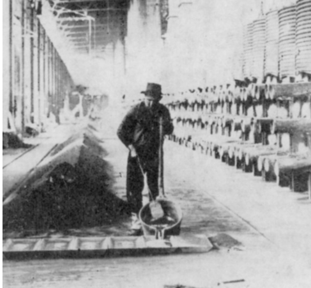
2. Dawnej konstrukcji piec muflowy do wytopu cynku (Górny Śląsk, 1930)
