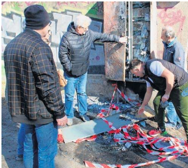
Mieszkańcy skarżą się na brak oświetlenia przy garażach, które użytkują
