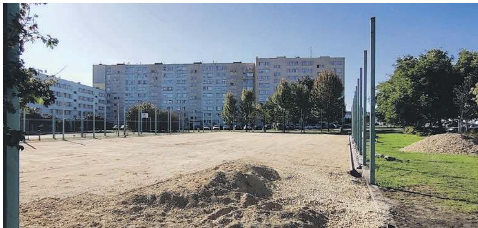
Przebudowywane boisko sportowe na osiedlu Trzebińska w Chrzanowie
