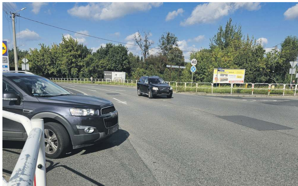
Skrzyżowanie Pogorskiej, Chechlanej i drogi wyjazdowej z Lidla w Chrzanowie
