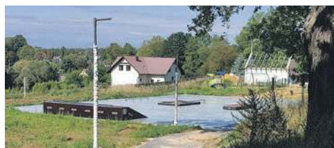
Budowa kompleksu rekreacyjnego w sąsiedztwie ul. Szembeków w Porębie Żegoty
