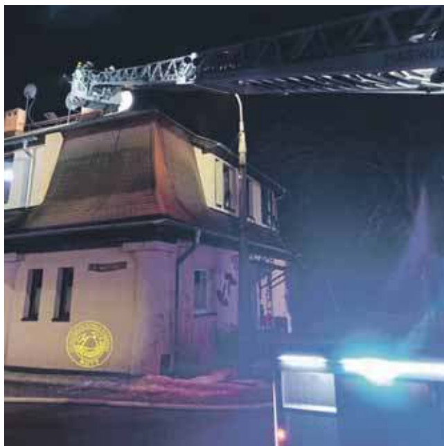
Ogień odciął pierwsze piętro i poddasze
