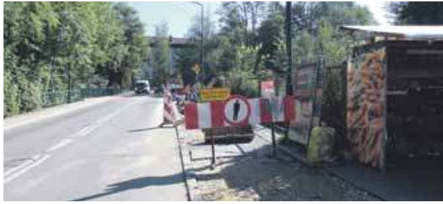
Praca przy Orkana wre - na moście, a przed warzywniakiem jedno wielkie zwirowisko.
