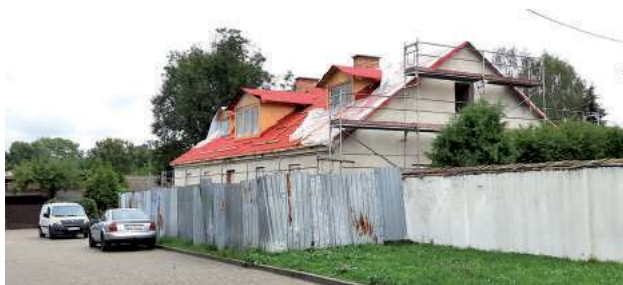
W budynku dawnej plebanii wciąż trwają prace remontowe. Za kilka tygodni wprowadzi się tu Gminne Centrum Kultury. Będzie działał także pierwszy w gminie Punkt Informacji Turystycznej
