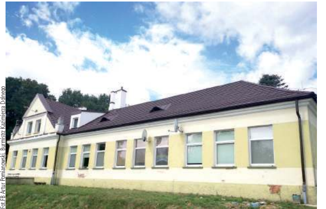
Dach na budynku szkoły były w fatalnym stanie. Na szczęście udało się go w porę wymienić
