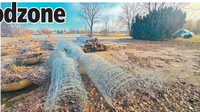
Prace na płońskich Rutkach już się rozpoczęły
