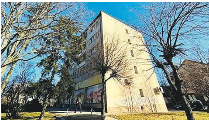
Lokale użytkowe zostaną przebudowane na mieszkania komunalne
