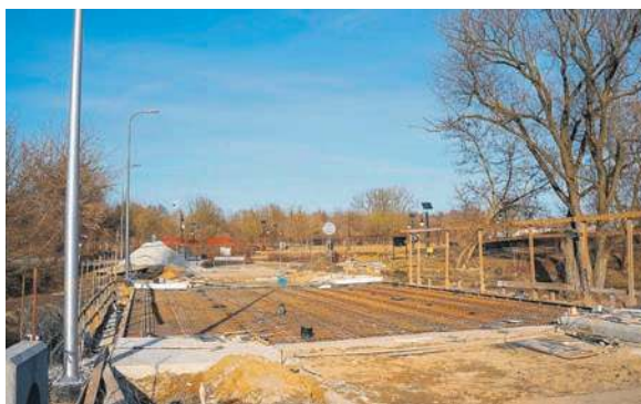
Budowa mostu na Łydni
