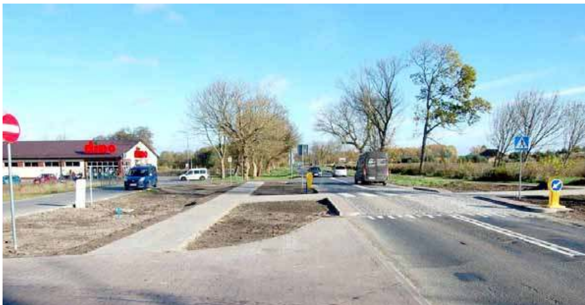
Przejście zostało wyniesione co zdecydowanie wpłynie na poprawę bezpieczeństwa pieszych
