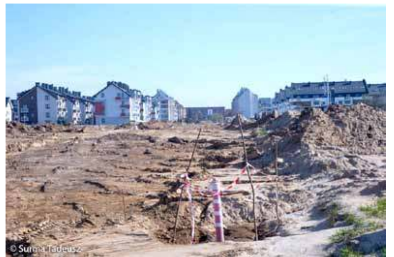
Miasto zdobyło dofinansowanie m.in. na budowę drogi KZ 2 na Os. Pyrzyckim
