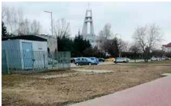
Nowe chodniki w parku Brzeziny II już wymagają naprawy
