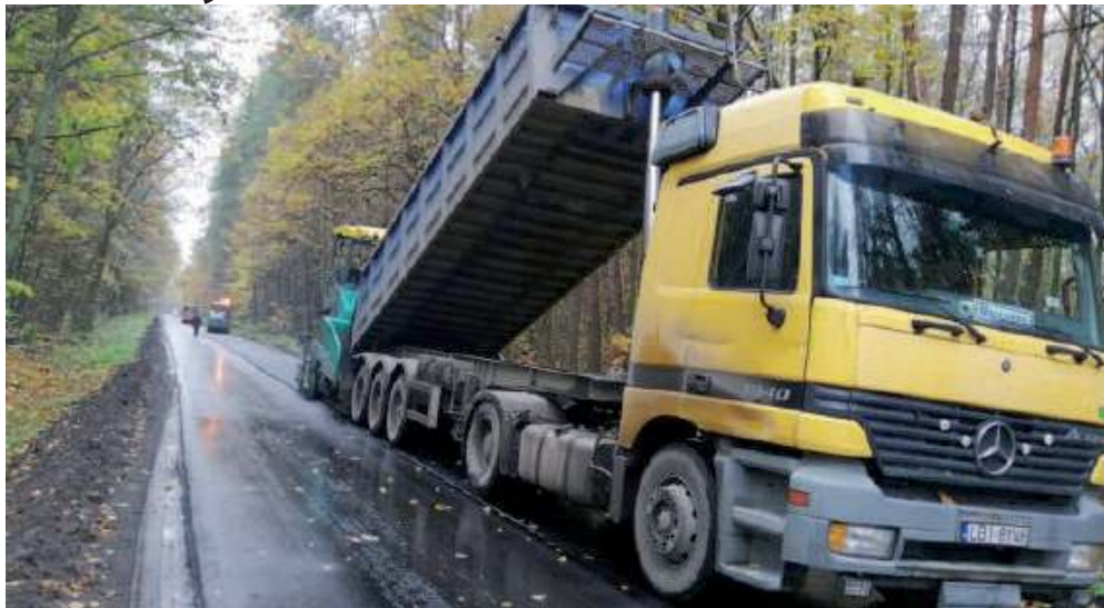
Remont drogi kosztował prawie 124 tys. zł
