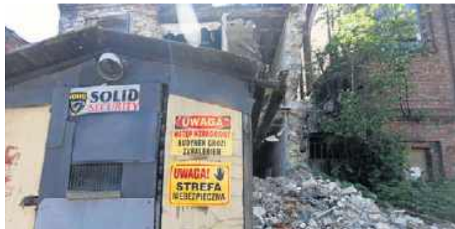
Ruiny dawnego Elanexu w Częstochowie - czerwiec 2026 r.
