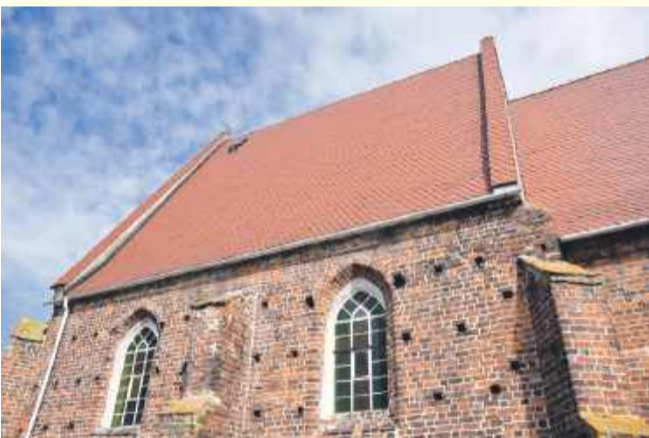
Ukończono remont dachu XV-wiecznego kościoła w Ozorowicach
