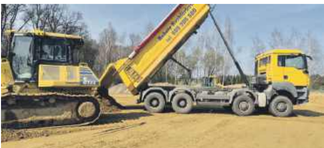
Obecnie trwają roboty ziemne, które obejmują wykonanie nasypu
