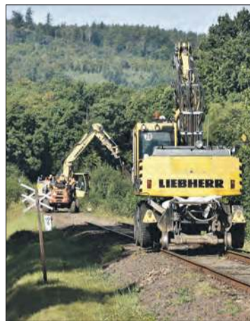
Remont linii obok przejazdu drogowego koło Wieszczyzny
