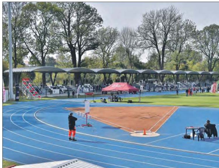
Trybuny po południowej stronie stadionu zostały zadaszone
