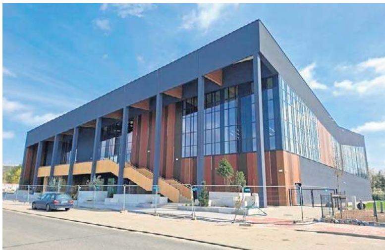
Zakończyły się prace budowlane przy basenie w Krzeszowicach
