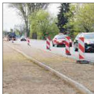
Trwa układanie kostki brukowej przy ul. Zamkowej
