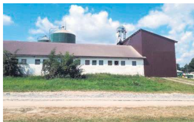
W chlewni w Dębach hodowanych jest około 1200 tuczników.
