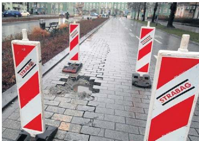
Wykonawcą prac było konsorcjum Roverpol i Rover Infraestructuras, które miało 16 miesięcy na realizację
