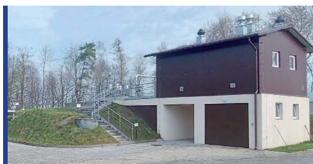
Modernizacja oczyszczalni ścieków w Starym Uścimowie
