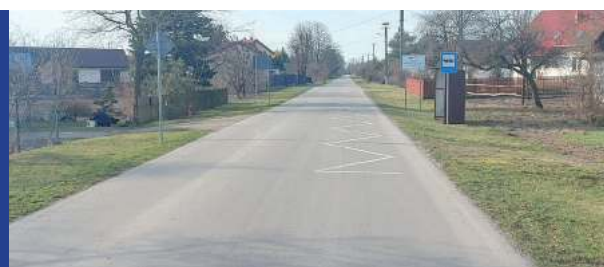
Przebudowa dróg gminnych
