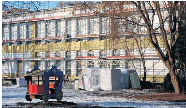
Przedszkole nr 66 przy ulicy Zapolskiej przechodzi gruntowną termomodernizację
