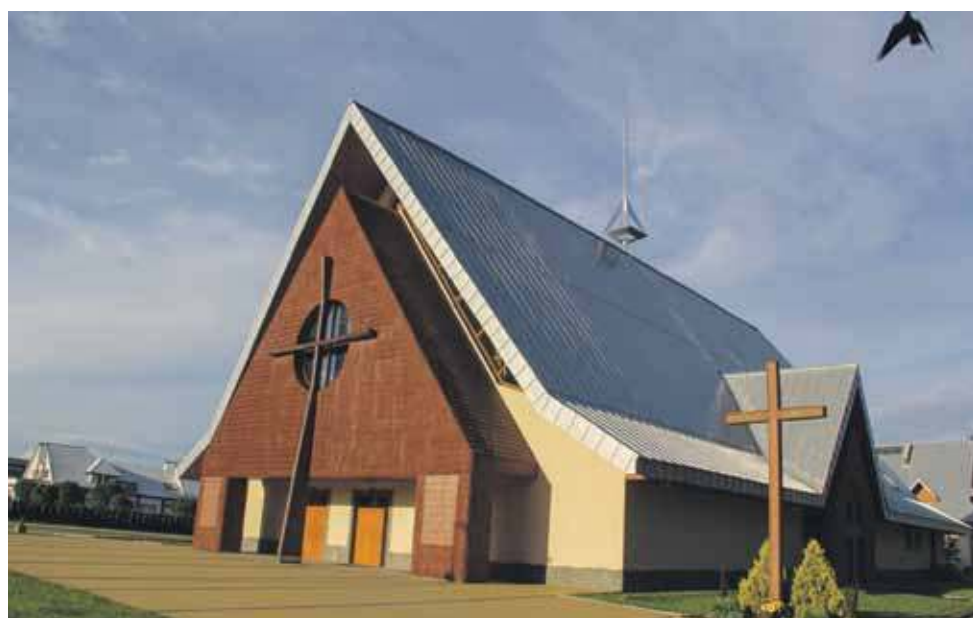
Przy ul. Szafarskiej przybyło nam sanktuarium.
