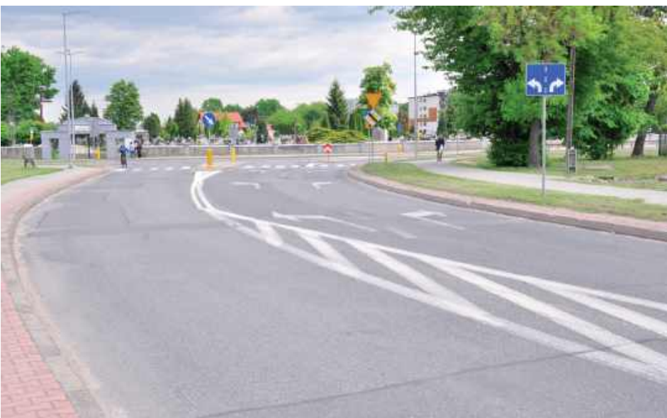
Droga zostanie dostosowana do standardów klasy GP, czyli głównej drogi ruchu przyspieszonego. Stara nawierzchnia zostanie rozebrana, a w jej miejsce powstanie nowa jezdnia o nośności 11,5 tony na oś
