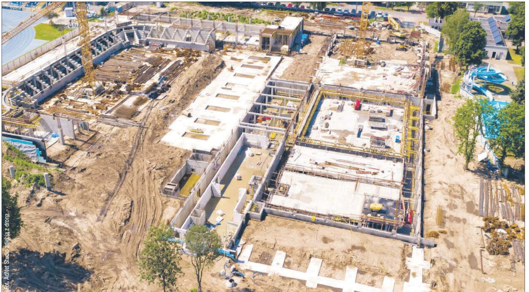
Budowa nowej hali widowiskowo-sportowej nie została storpedowana przez pandemię koronawirusa. Prace cały czas postępują.
