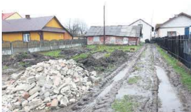
Nim przystąpiono do pracy, trzeba było rozebrać stary budynek i uporządkować działkę.
