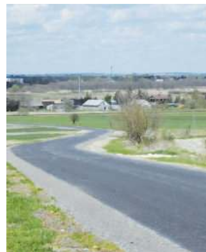
Droga gminna nr 110377L – Lipowiec-Kolonia
