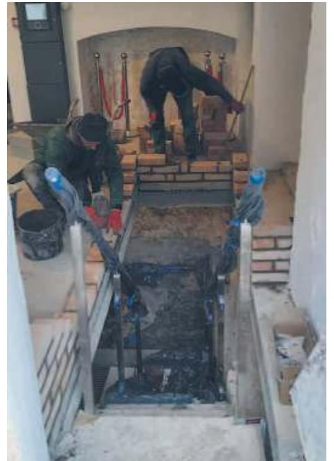
Obecne prace w kryptach
