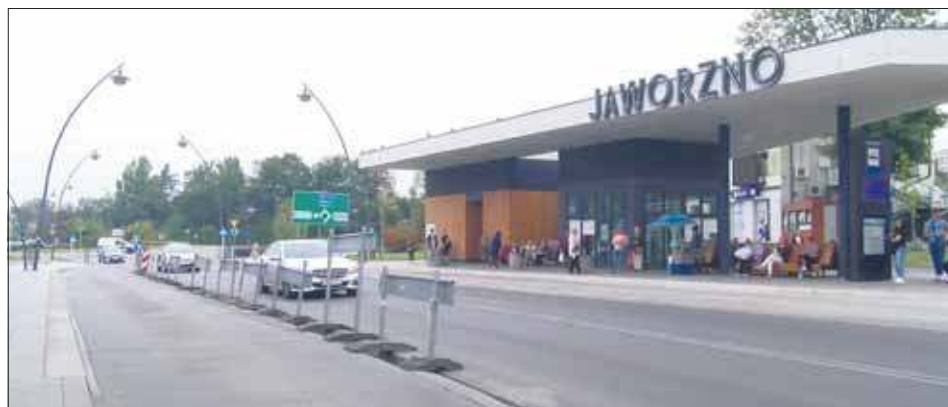
Remont zatok ciągnie się już od wielu miesięcy
