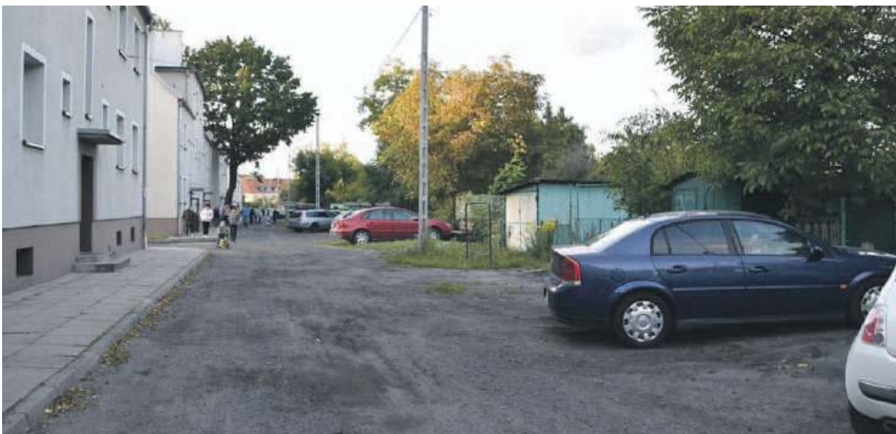
Dawniej przy budynkach na ul. Opolskiej były podwórka. Obecnie jest żużlowa droga i pas zieleni z ogródkami, których część dzierżawią mieszkańcy. Teraz otrzymali wypowiedzenia umów. W miejscu zieleni ma stanąć kolejny blok i garaże
