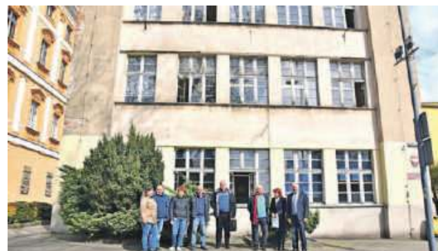
22 kwietnia w budynku Tajwanu podpisano protokół przekazania placu i terenu budowy. Na zdjęciu przedstawiciele starostwa, dyrektor LO Nr I, a także reprezentanci wykonawcy firmy „Domus”
