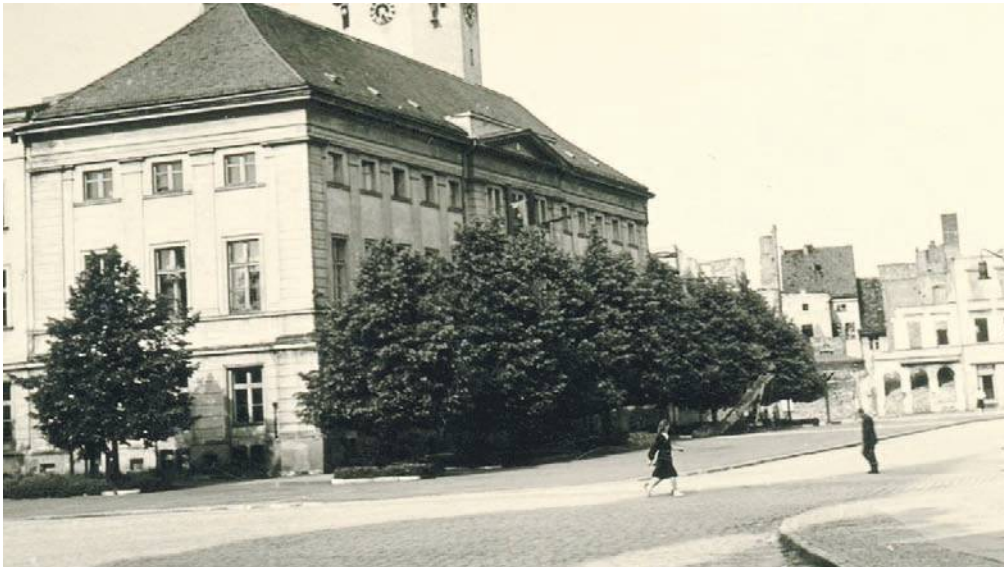
4. Zdjęcie z 1947 roku, na którym w głębi widzimy wypalone budynki ściany wschodniej. Proszę zwrócić uwagę, jak wyglądał plac rynkowy zaraz po wojnie
