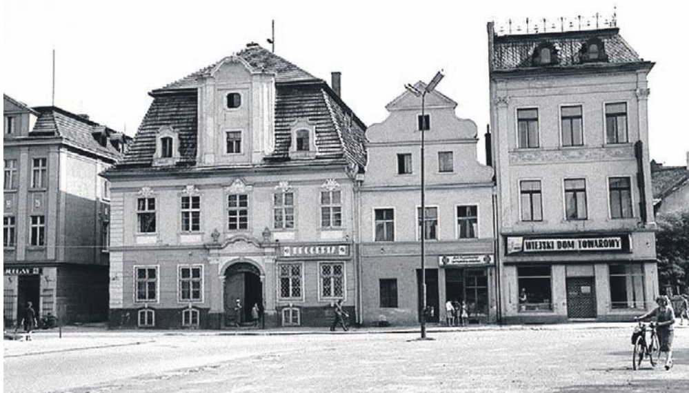
9. Rok 1966 - od prawej budynek, w którym przez lata był Wiejski Dom Towarowy, W budynku środkowym na parterze po wojnie była piekarnia, potem ciastkarnia, a na piętrze były mieszkania. Budynek po lewej to tzw. Pałac Ślubów od 1976 roku, wcześniej były tam mieszkania i Klub „Ruchu”. Fot. Lesław Mazur
