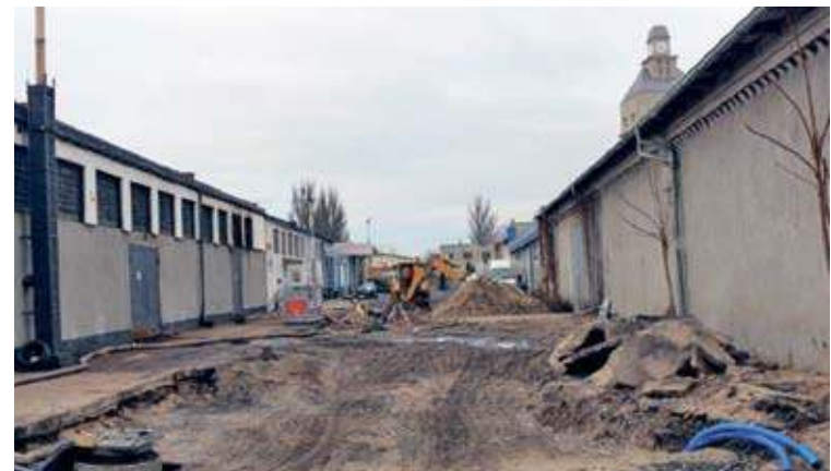
Prace budowlane są kontynuowane także na terenie starej „Odry”
