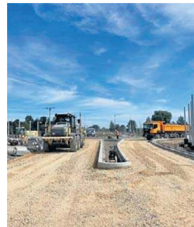
Na obwodnicy Zabierzowa trwają prace przy budowie tunelu
