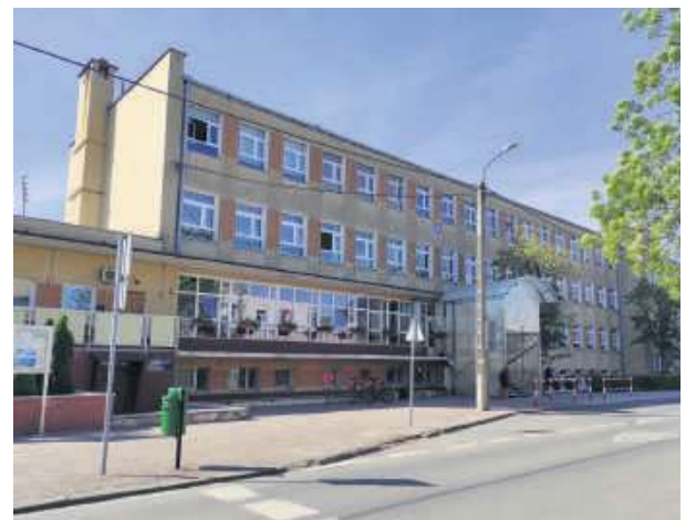
W ramach termomodernizacji Szkoły Podstawowej nr 4 w Strzelinie zostanie zamontowana winda zewnętrzna dla osób niepełnosprawnych
