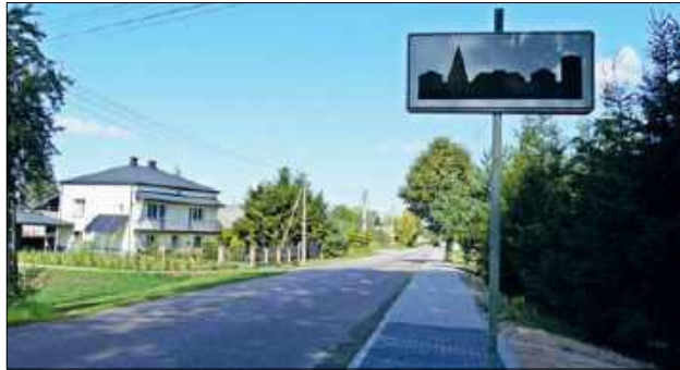
Budowa chodnika w Olszewnicy była możliwa dzięki porozumieniu samorządów i firmy prywatnej, a mieszkańcy dołożyli fundusz sołecki do budowy odcinka przy drodze gminnej
