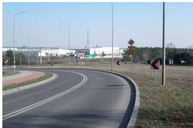
Tu ma być początek obwodnicy od strony ulicy Gdynskiej
