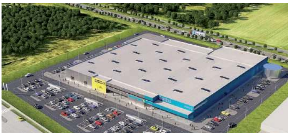
Bialska Castorama to hala główna o powierzchni 8 tys. mkw., pozostałą część stanowią będzie magazyn i pomieszczenia biurowe
