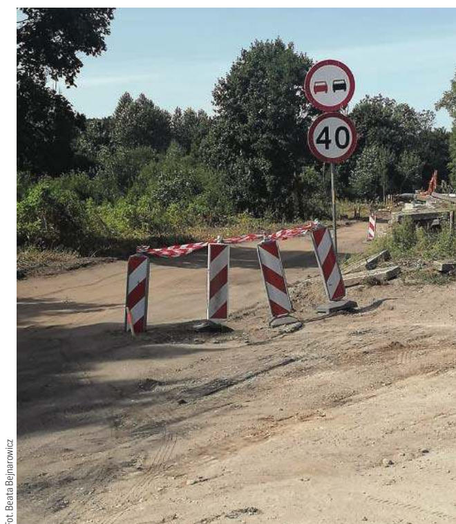
Przebudowa drogi zablokuje dojazd do sklepu
