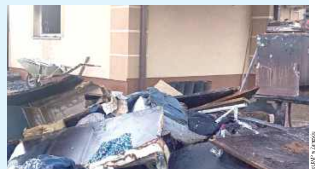
W wyniku pożaru spaleni uległy wnętrza pomieszczeń piętrowego murowanego domu
