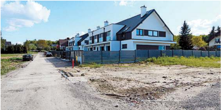
Jest szansa, że przy okazji kosztującej wiele milionów budowy Al. NSZZ „Solidarność” powstanie również kawałek ulicy prowadzący do domów jednorodzinnych stojących w pobliżu zbiegu alei z ulicą Kusocińskiego
