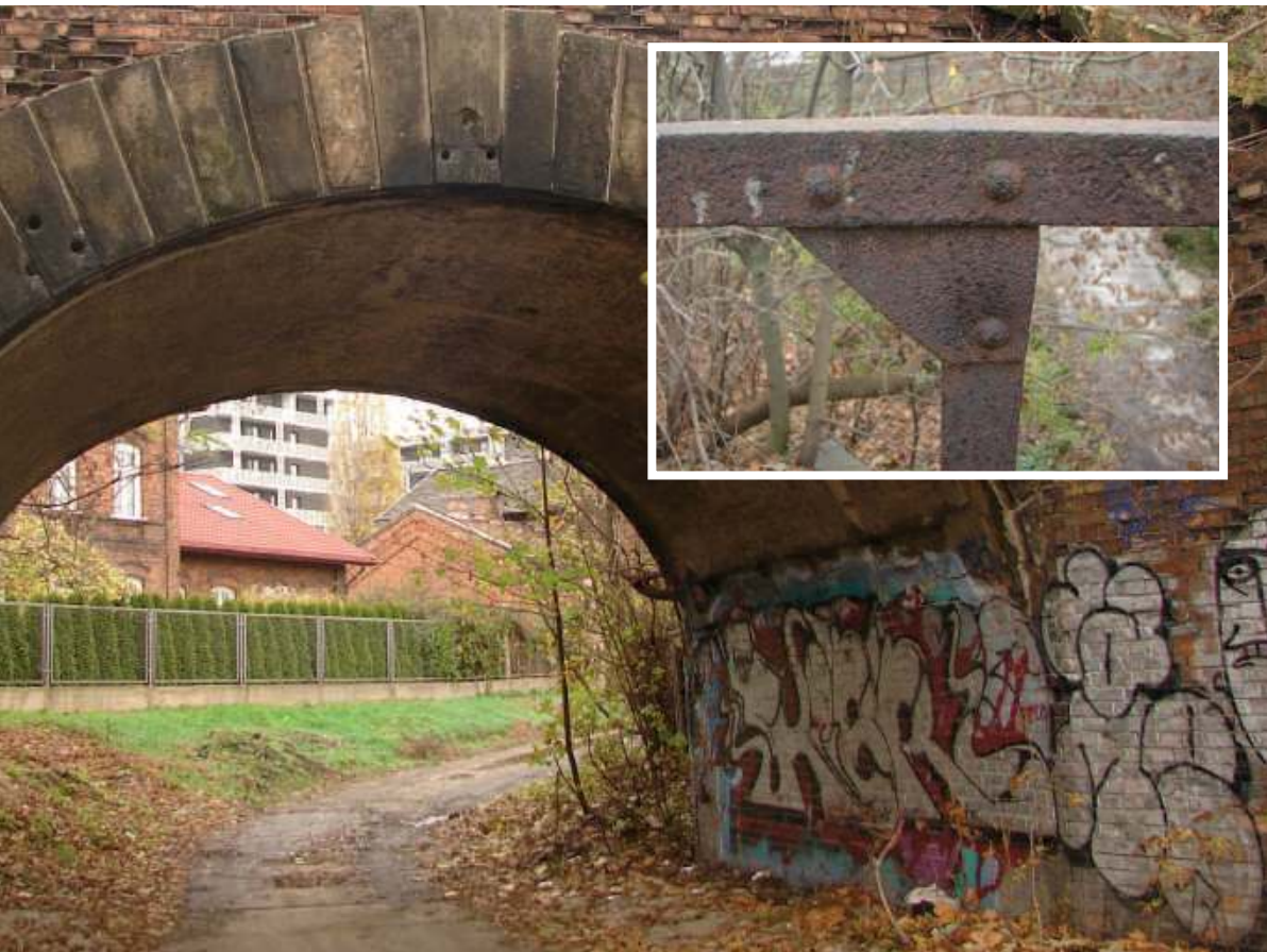
Zabytkowy wiadukt przy ul. Armatniej i fragment nitowanej balustrady | fot. Janusz Sujecki/Gazeta Polska
