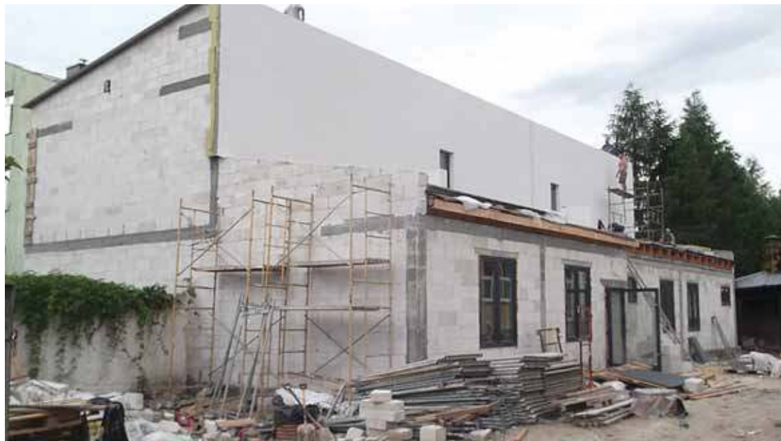
Budowa Powiatowego Centrum Opiekuńczo-Mieszkalnego w Mławie. Ta inwestycja, w całości finansowana z Funduszu Solidarnościowego, będzie ukończona w br.
