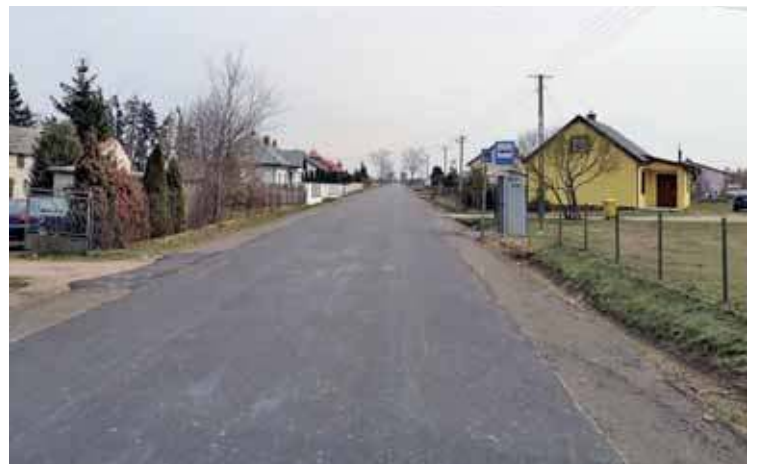
Fragment zmodernizowanej drogi
