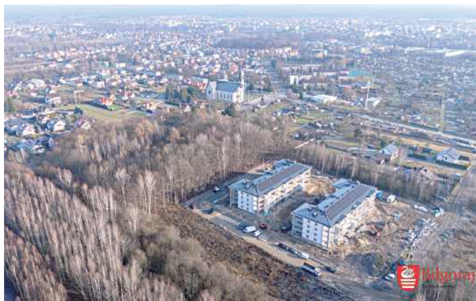
Powstają nowoczesne budynki, które mają poprawić dostępność mieszkań i komfort życia mieszkańców
